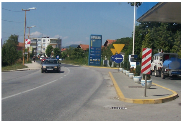
Fotografija 12. Izbjedljivi i pogrešno okrenuti znakovi
