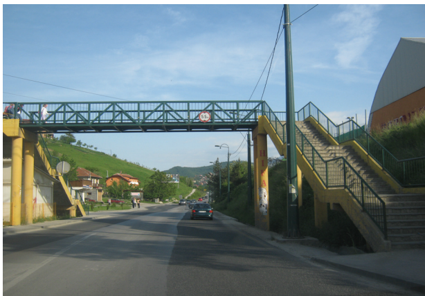
Fotografija 19. Nezaštićeni stubovi – objekti
