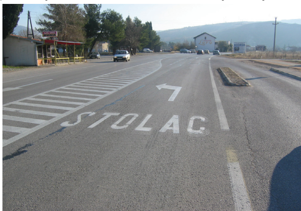
Fotografija 16. Pogrešna horizontalna signalizacija
