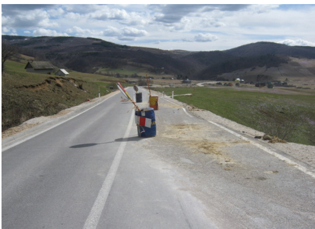
Fotografija 21. Nedostatak pasivne sigurnosne instalacije
