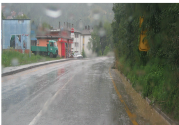
Fotografija 15. Žbunom sakrivena signalizacija
