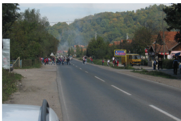
Fotografija 13. Primjer neobilježenog, nezaštićenog i nedostajućeg pješačkog prijelaza
