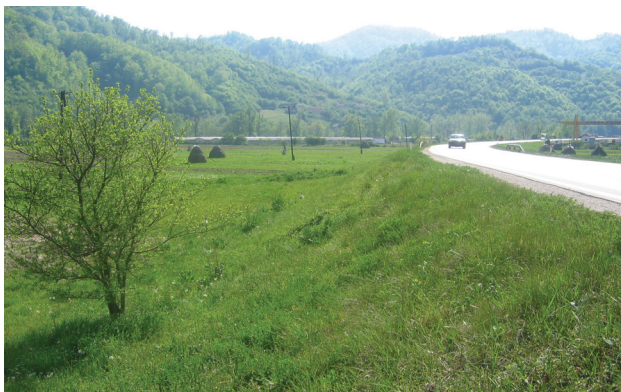
Fotografija 20. Visoki i strmi nasip bez zaštitne ograde
