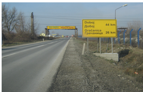
Fotografija 18. Nezaštićeni temelji potvrde pravca - jarak
