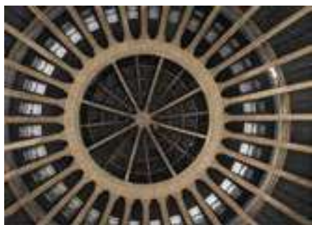
Slike 4.-6. Milenijska dvorana u Wrocławu, tankostijena krovna konstrukcija, prva reprezentativna građevina kojom iznutra i izvana dominira beton 4
