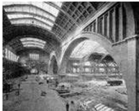
Slike 1.-3. Betonske konstrukcije krajem XIX. i početkom XX. st.: zasvođeni bazen u Hebevilleu (1896), zasvođena tržnica u Münchenu (1912) i Centralna željeznička stanica u Leipzigu (1915) 3
