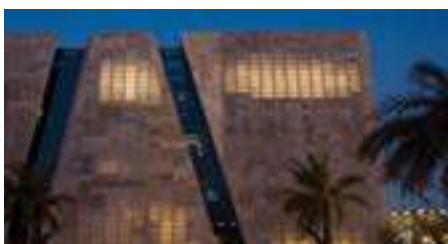
Slike 28.-30. Primjeri primjene „prozirnog“ betona: na slici desno je vanjšina Talijanskog paviljona za Expo Shanghai (2010) sa više od 3.200 betonskih panela koji pokrivaju površinu od 20.311 m 2 . Kako se mijenja vanjsko svjetlo tijekom dana, građevina dobija različite tonove i oblike za dramatičan efekt 32
