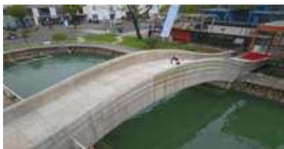
Slike 36.-37. 3D printani betonski mostovi u gradovima 36,37
