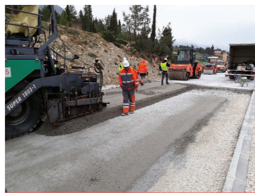
➔ Slika 15: Postavljanje kolnika od uvaljanog betona
