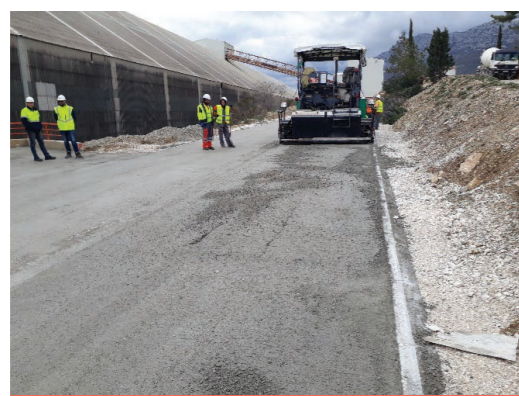
➔ Slika 16: Završni radovi prilikom ugradnje uvaljanog betona
