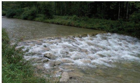
Slika 13. Renaturisana barijera na rijeci Auerbach: rampa od kamena odgovarajuće veličine [2]
