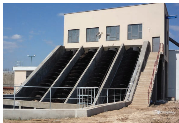
Slika 1. Ulazna pumpna stanica
