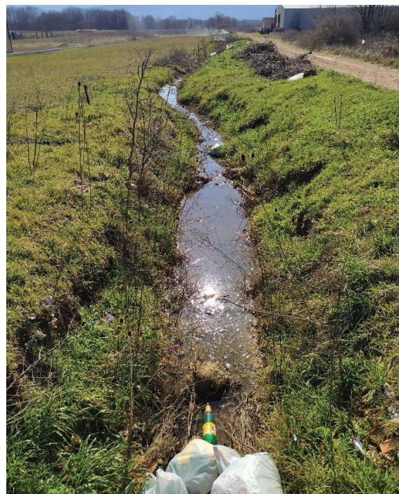
Slika 2. Postojeći odvodno natapni kanal
