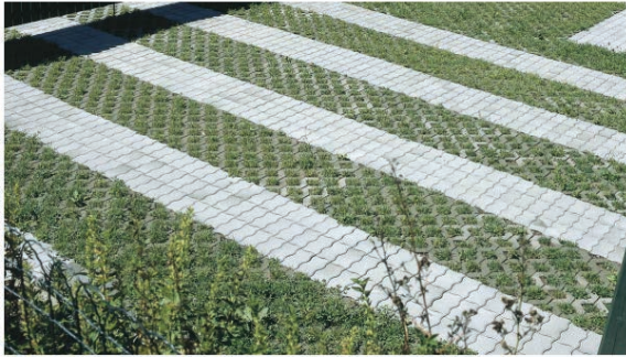
Slika 5. Prikaz betonske travnate rešetke [10]
