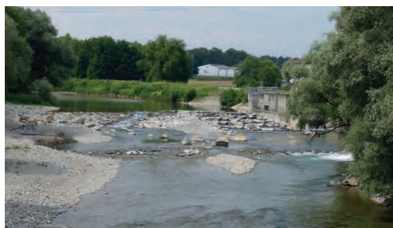
Slika 9. Renaturizacija (uklanjanje) brane na rijeci Alz bei Burgkirchen sa podijeljenim strukturama: hrapava staza sa bazenima i hrapava staza sa lomljenim kamenjem izmedju kojih se nalazi staza za prolaz kanua (kajaka), završena juna 2015 [2]
