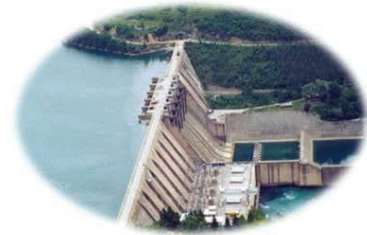
Pumpno-akumulacijska hidroelektrana "Čaplina"
